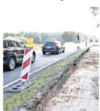
Tangente: Behinderungen durch Radwegbau. FOTO: ARCHIV
